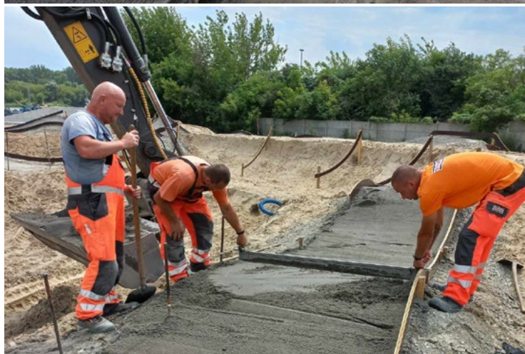
Fot. Prace przy budowaniu toru pumptracku
