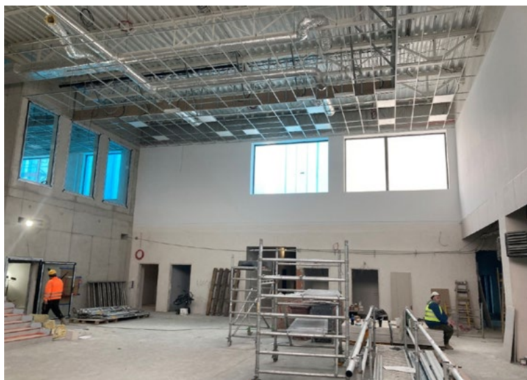
Fot. Parter SOR w trakcie budowy oraz w dniu otwarcia
