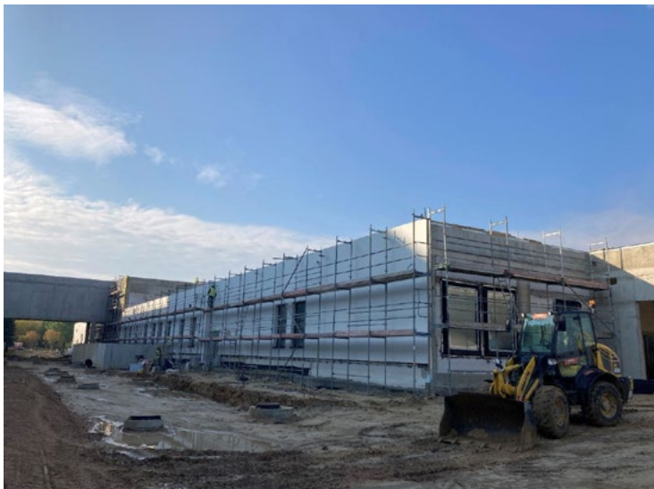
Fot. Powstający pawilon SOR, w tle wybudowany łącznik z budynkiem szpitala
