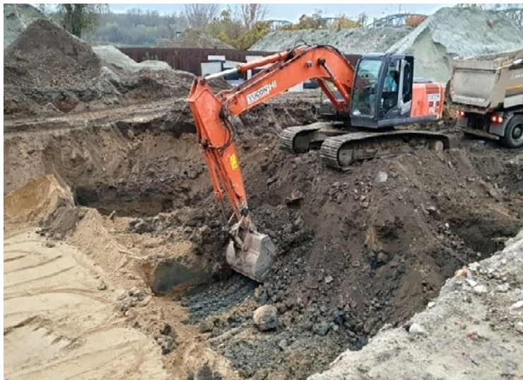
Fot. Prace przy wymianach gruntu
