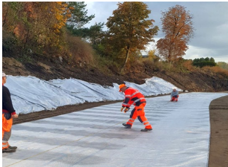
Fot. Układanie materaca PVA
